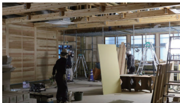
ホールも着々と完成に近づいています
